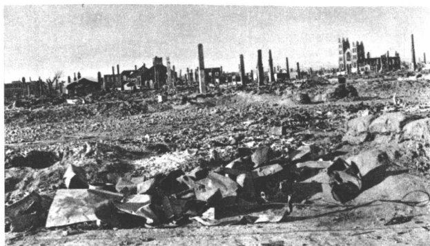
(5329) 鸭绿江畔的新义州到处是残垣断壁。
