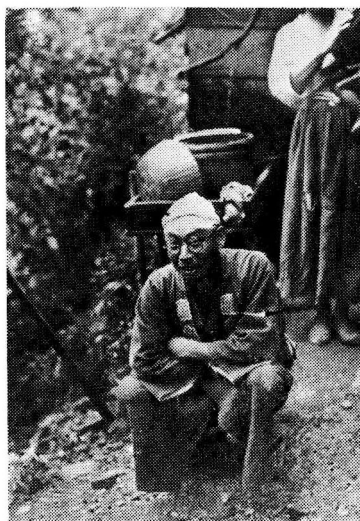
天龍川畔の飯田線敷設工事で
