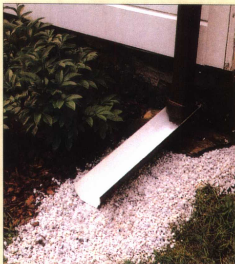
水落管。 如果有排水槽,可以用水落管导出水流,以保护屋基。
