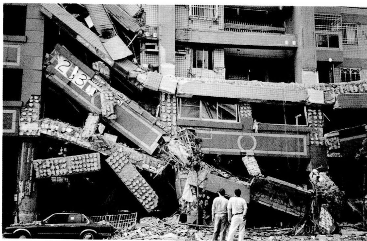
この建物は耐震建築といわれていたが・・・
