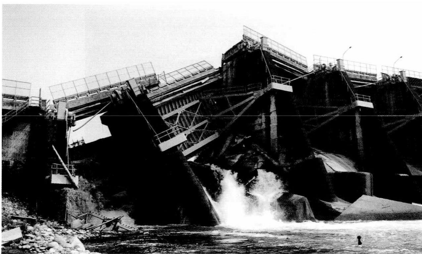
すさまじく破壊された石岡ダム
