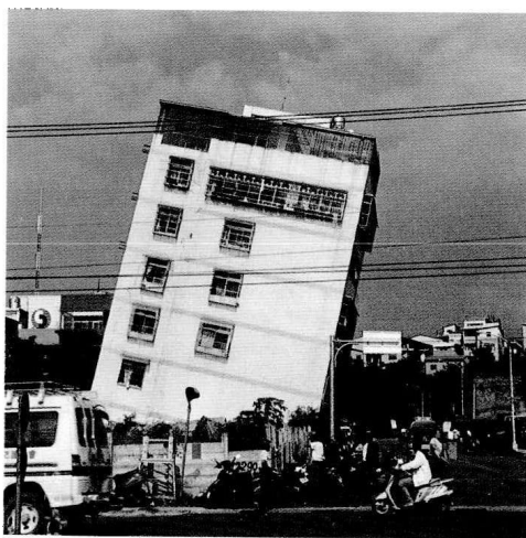
大きく傾いた建て物。 いつ倒壊するかわからない(東勢地区)
