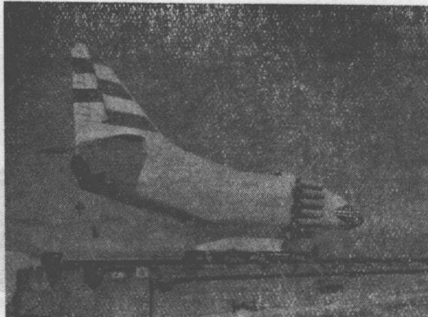
说明：道格拉斯飞机公司的A4D飞机，在海军军械滑轨上进行尾翼颤振试验，后机身底部与滑车结合在一起。此试验是为了检查飞机控制面的气动颤振特性。
