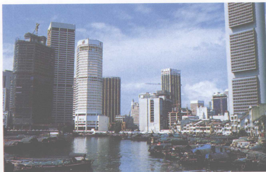
图 13 “明日之窗”新加坡：摩天大厦阴影下的旧乌棚船
