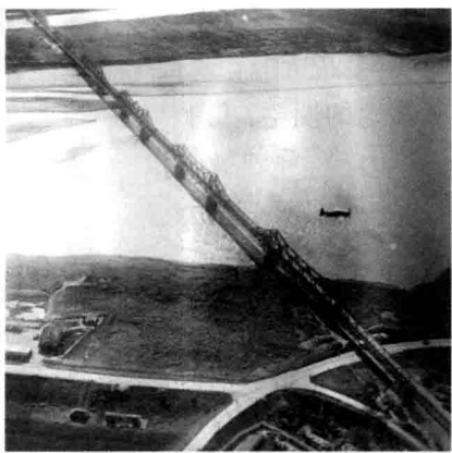
▲ 越南龙边大桥实景
