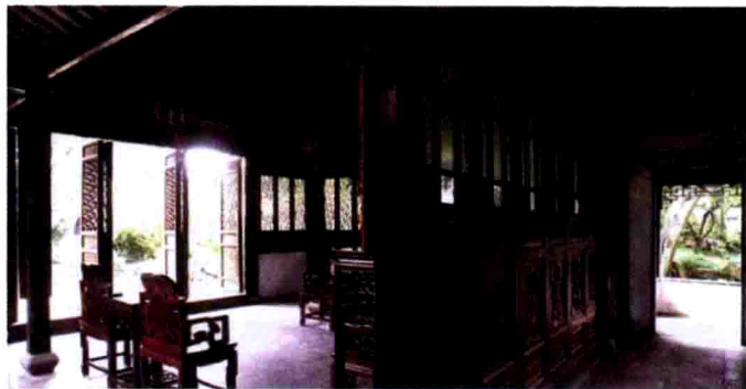
图 1.12 苏州拙政园玲珑馆内隔扇,把空间分两部分
