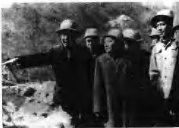
▲邓小平在甘肃刘家峡水电站工地视察
