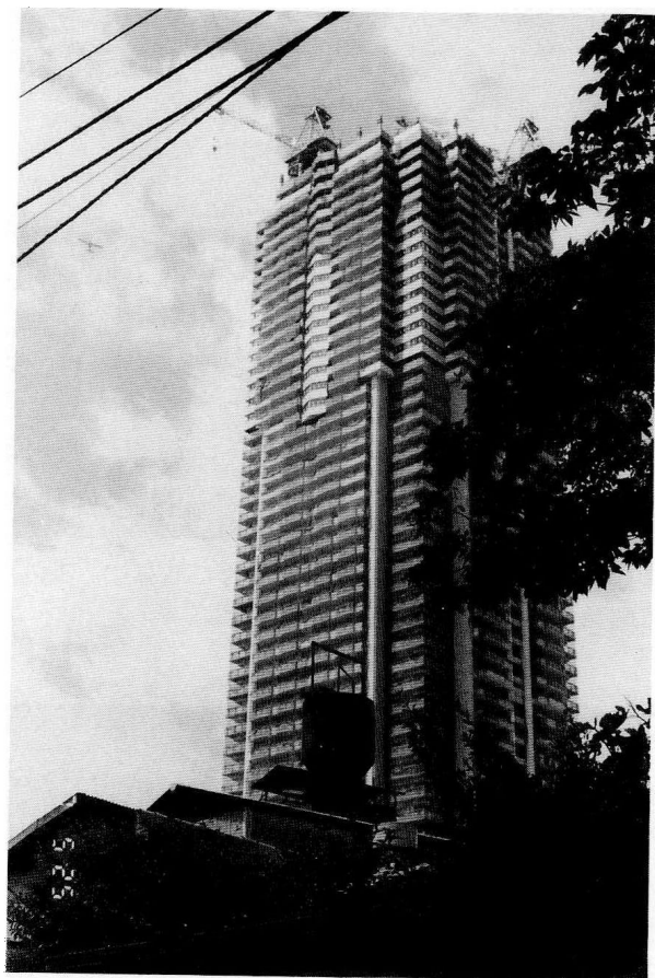
後はエルザタワー 55 現在工事中である。
