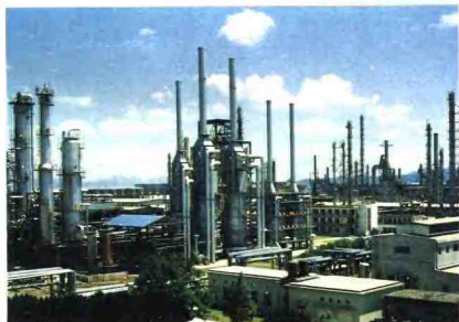
建成后的镇海炼化股份有限公司炼油二期工程(局部)。
