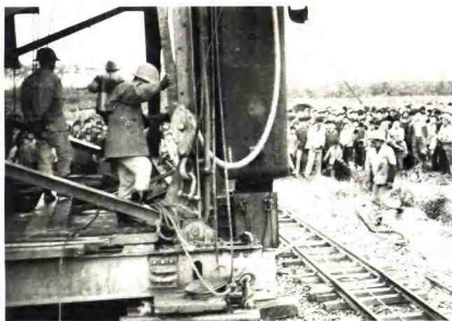
1973年5月23日，海盐桶田上打下第一根桩，揭开了浙江炼油厂建设的序幕。
