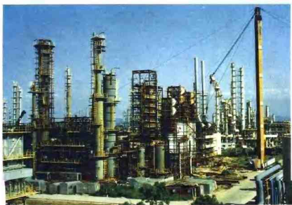
建设中的镇海炼化股份有限公司炼油二期工程(局部)。
