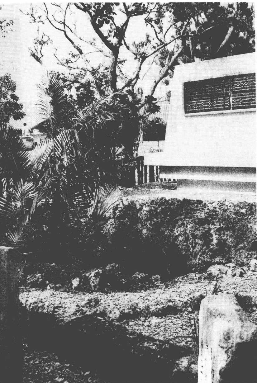
伊原の第三外科壕入口
