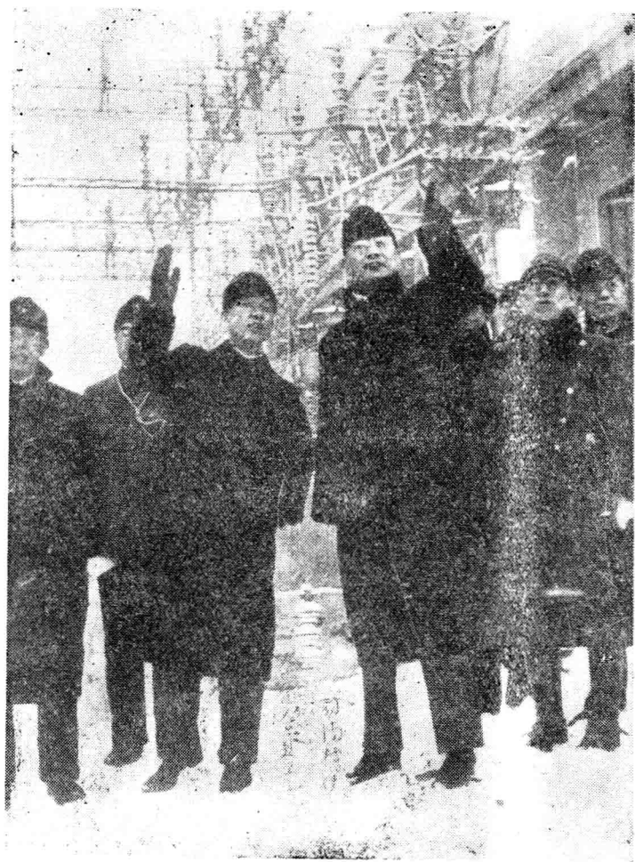
访“满”特使周佛海参观小丰满水电站
