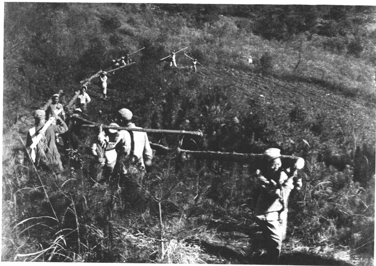
(6020) 机关工作人员从远处把木料抬到前沿阵地，帮助战士修筑坑道工事。
