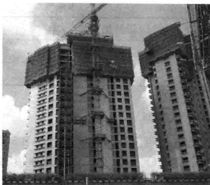
(b) 钢筋混凝土墙承重体系
