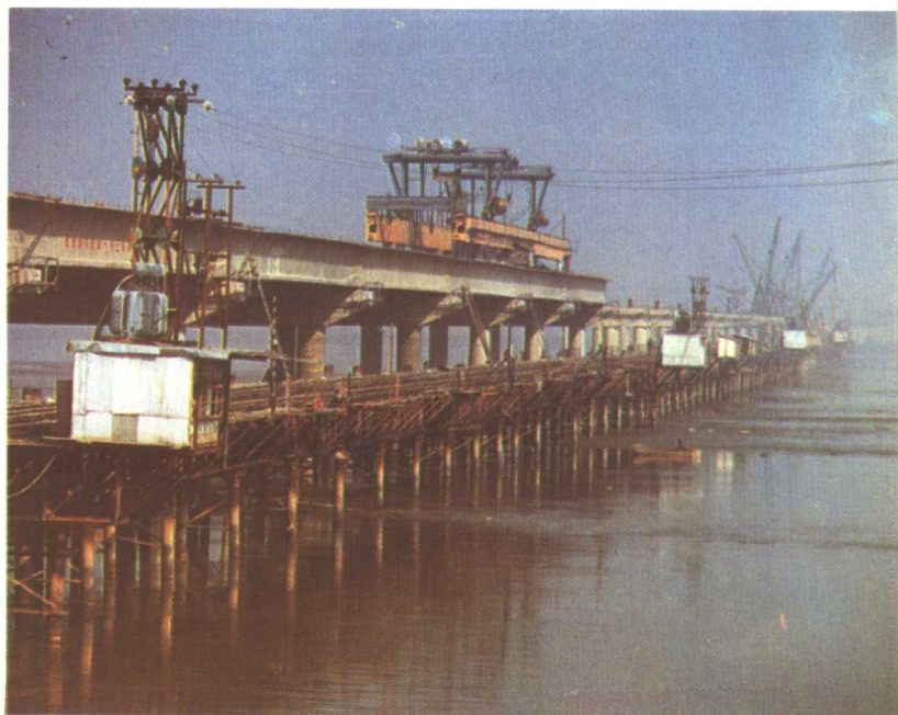
建设中的黄河大桥。
