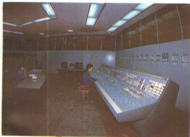
姚孟电厂四号机组采用电子程序控制的主控室。
