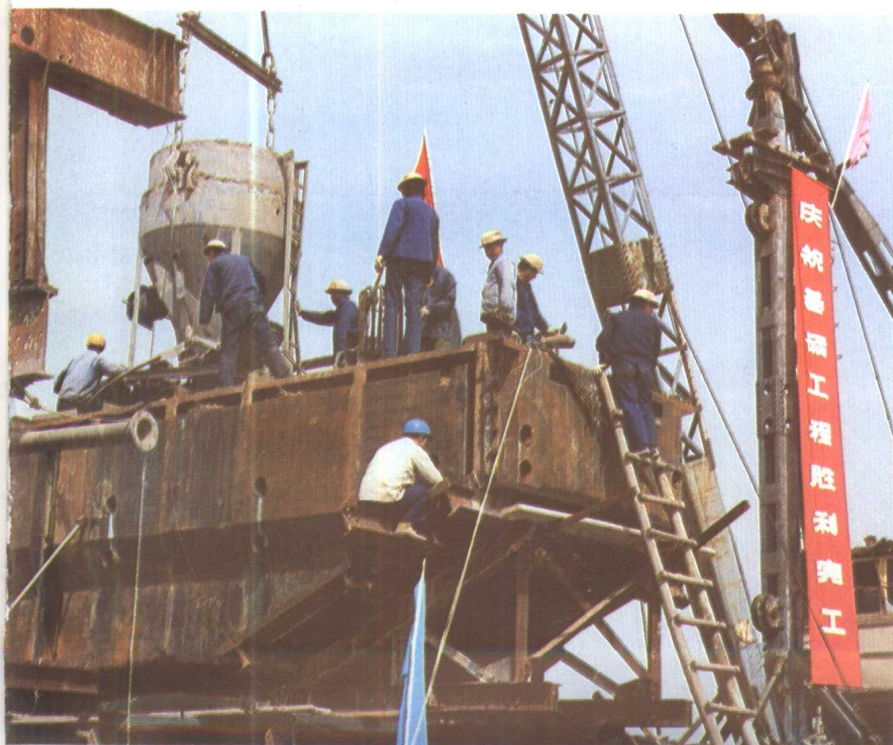
大桥基础工程胜利完工。
