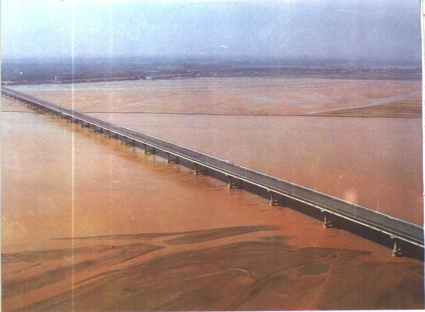
郑州黄河公路大桥。
