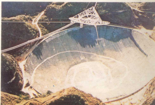
▶ 位于波多黎各的美国制造的射电望远镜，底座是个死火山口，天线直径366米，为世界之最。
