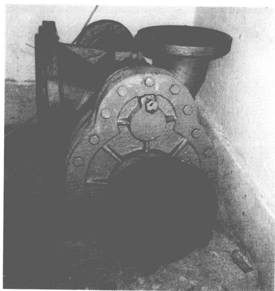
1990年4月11日 汤仲明先生的半 园凸轮转子泵， 获国家发明专利 CN86105874A
