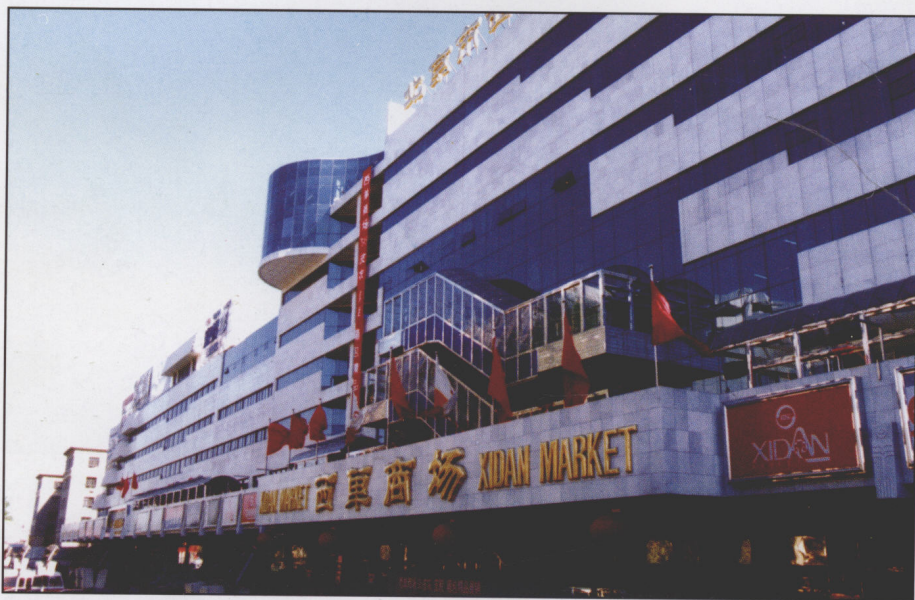
图 0-3 经过改建、扩建与装修的北京市西单商场
