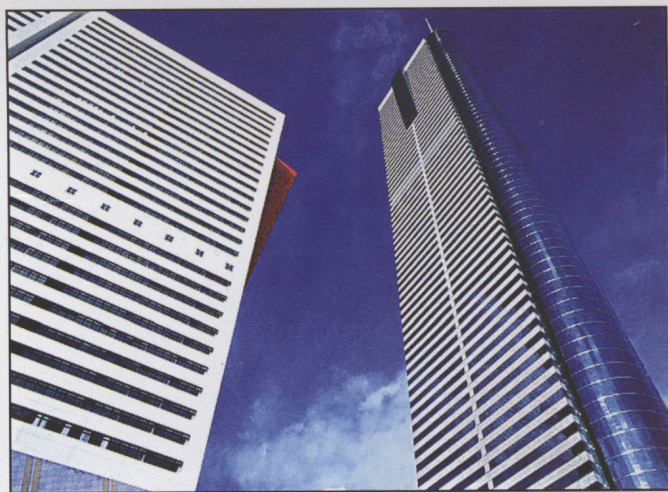
图 0-7 深圳市地王商业大厦是 20 世纪 90 年代落成的一座多功能现代化商业大厦,其购物裙楼将两个主体建筑连接一起,形成深圳市气势恢弘的美丽城市天际轮廓线上的典型景观
