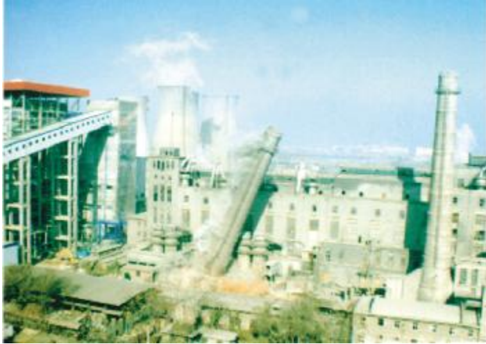
石家庄热电厂八期“以大代小”技改工程。图为 2002 年 11 月 25 日，该厂 1 号烟囱定向爆破，老机组退役。
