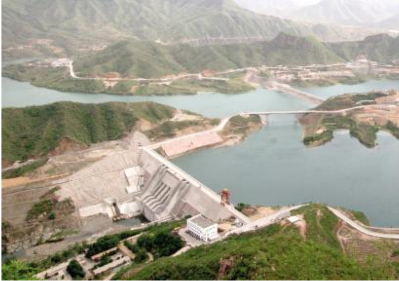
张河湾抽水蓄能电站是河北省利用亚洲开发银行贷款建设的大型水电项目,总容量 100 万千瓦。图为张河湾电站下水库。
