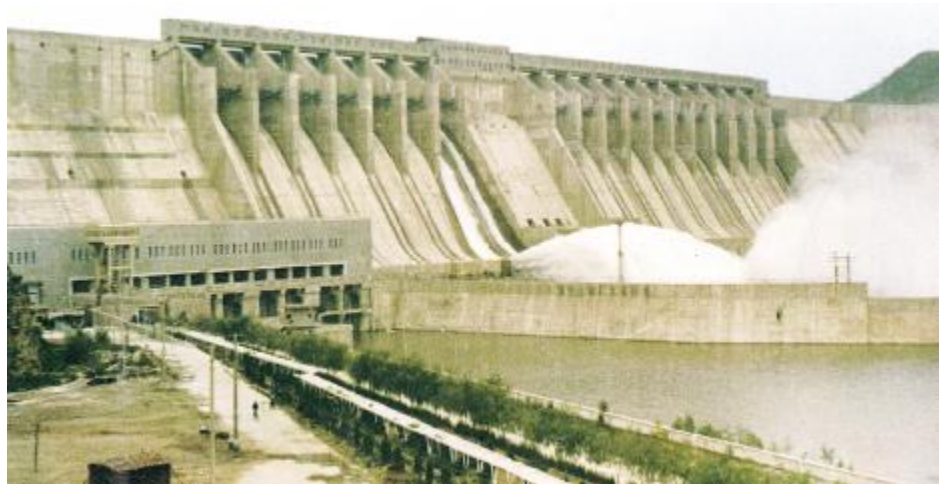
1993 年建成投产的潘家口抽水蓄能电站,装机 3 台,总容量 27 万千瓦。图为潘家口抽水蓄能电站全景。
