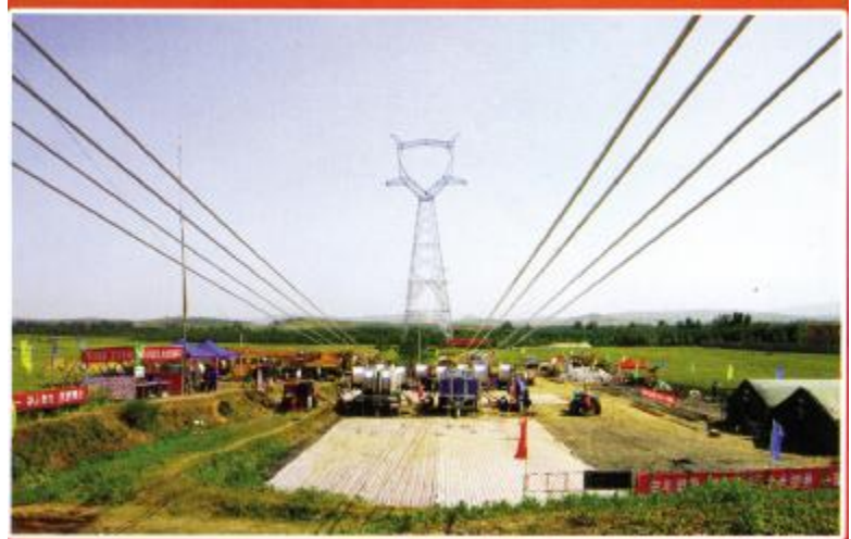
河北省送变电公司研制的电力线路施工机动绞磨曾荣获全国科学大会奖。图为 500 千伏输电线路施工一牵八放线现场。
