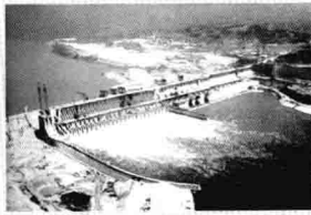
▼ 项目在山峡水利枢纽工程中的运用（使用部位：导流底孔封）
