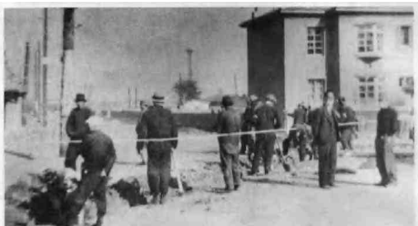
1940年“新京”防疫时，满铁工事事务所工人进行封锁作业，埋设铅铁板
