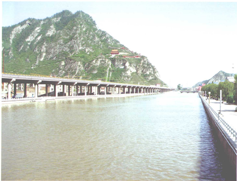
设施完备的水利枢纽——北川河橡胶坝
