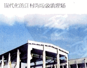
现代化的江村沟垃圾填埋场
