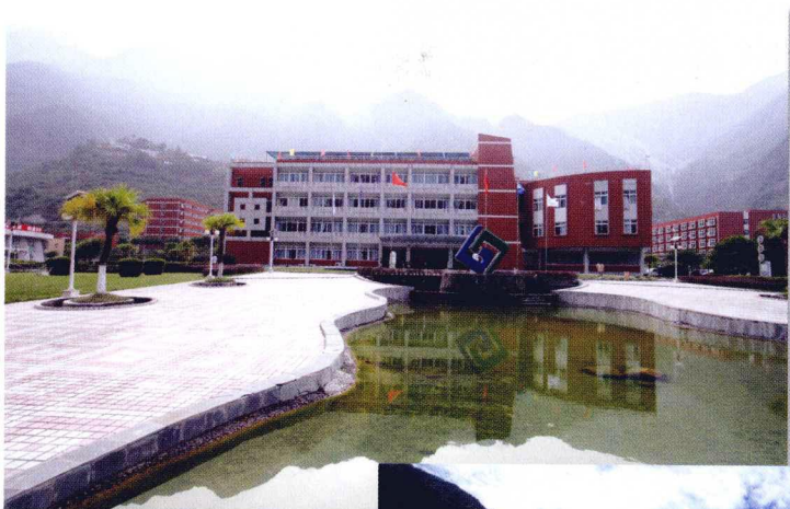
瀑布沟水电站建设营地办公楼（曾誉 摄）
