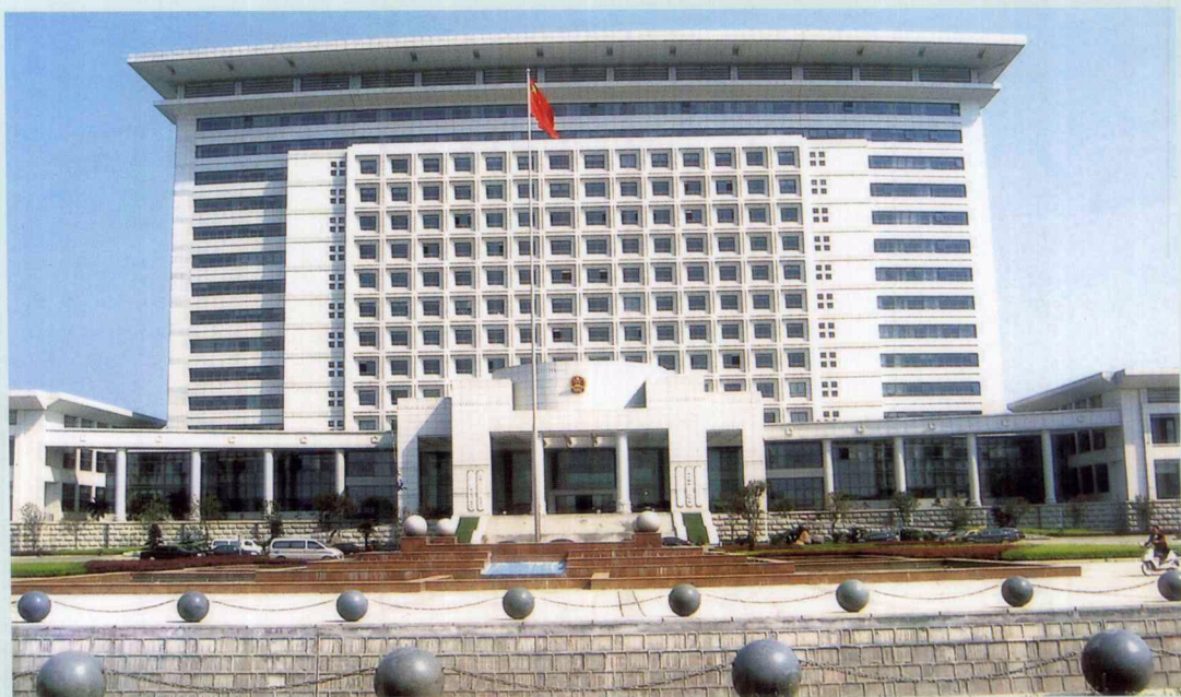
■ 鄞州新城区惠风东路区政协新址
