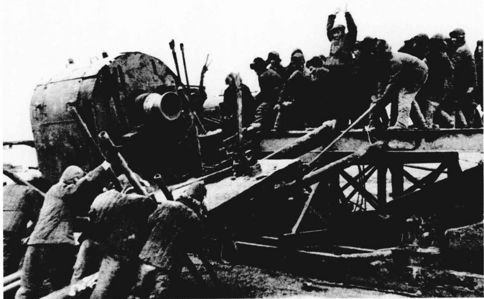
会战物资运到大庆后, 由于没有大型吊装设备, 王进喜带领井队人拉肩扛搬运钻机
