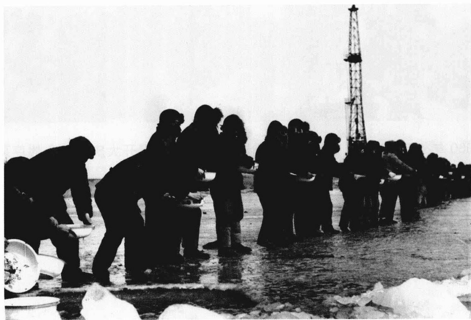
1205 钻井队到大庆打第一口井——萨 55 井时, 井场没有水, 王 进喜不等不靠, 带领大家破冰端水保开钻
