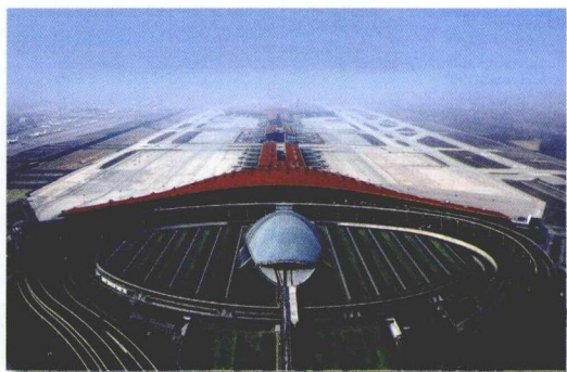
北京首都机场3号航站楼全景。 (中国交通年鉴社民航分部 供稿)
