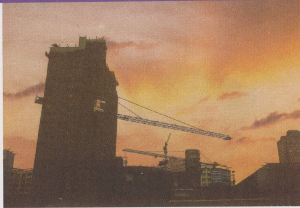
正在新建的丰都县城工地
