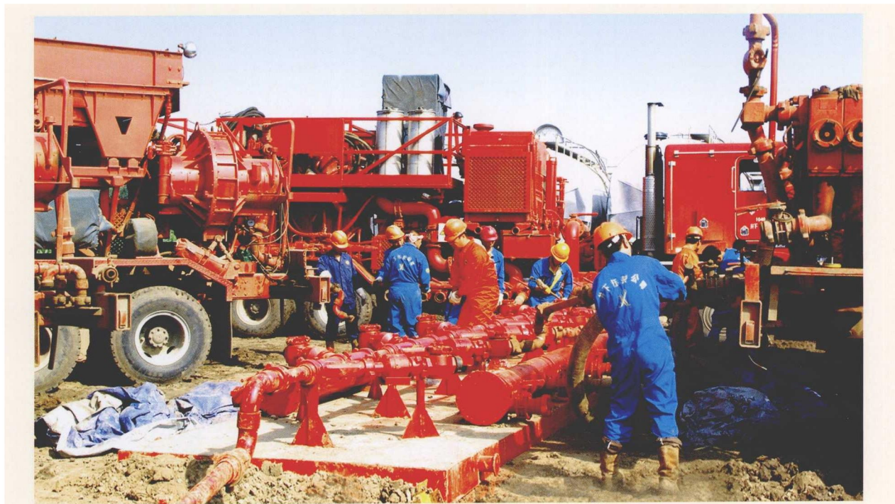
2008 年，中国石油天然气集团公司全面完成各项业绩目标，实现了持续有效平稳较快发展。全年实现营业收入 12730 亿元，上缴税费 2395 亿元，利润总额 1348 亿元。图为大庆油田产能建设现场
