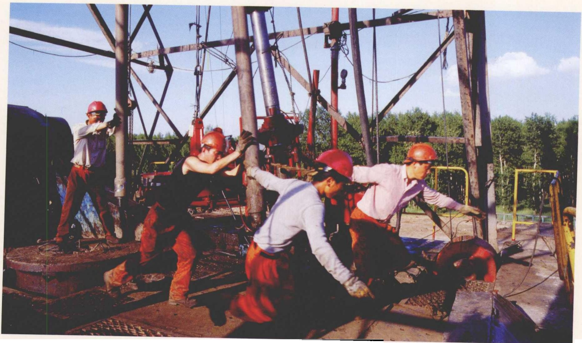
2008 年，中国石油天然气集团公司工程技术、工程建设和装备制造等业务的专业化服务保障能力和市场竞争能力得到进一步增强。图为海拉尔钻井作业现场
