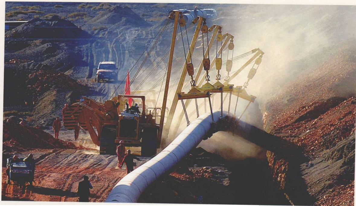
2008年2月，西气东输二线正式开工建设，工程以宁夏中卫为界，分东西两线进行施工，计划2011年年底全线贯通投入运营。图为西气东输二线工程
