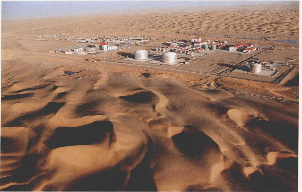
2008 年，塔里木天然气产量突破 170 亿立方米，继续保持中国第一大气区地位。图为塔里木塔中油田
