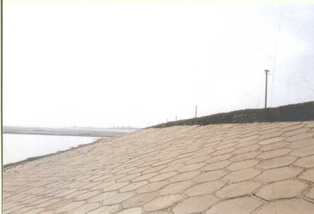
▲ 块石护岸、护坡
