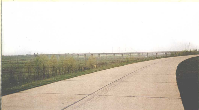
▲ 地处万城的荆江大堤（古荆江大堤称“万城大堤”）
