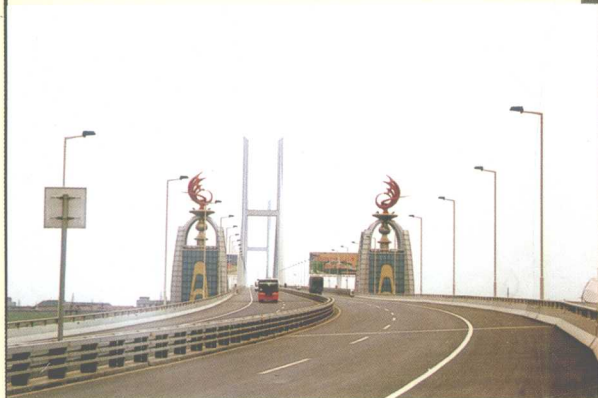
▲ 荆州长江大桥
