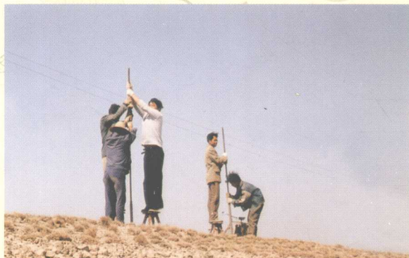
▲ 打孔灌浆夯实大堤
