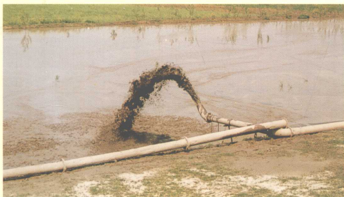
▲ 挖泥船吹筑堤脚
