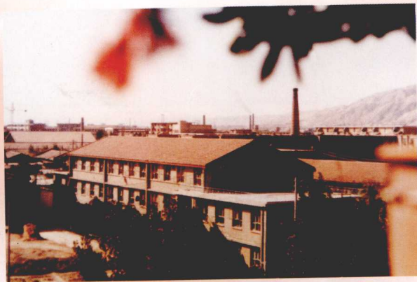
原住院部内、外科楼
