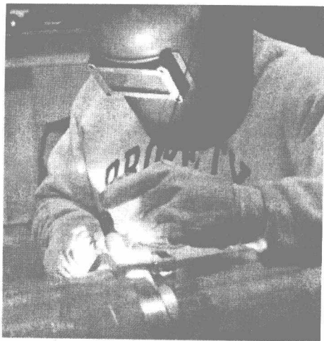
图 1.5 不锈钢管的焊接 (美国焊接学会焊接杂志)
