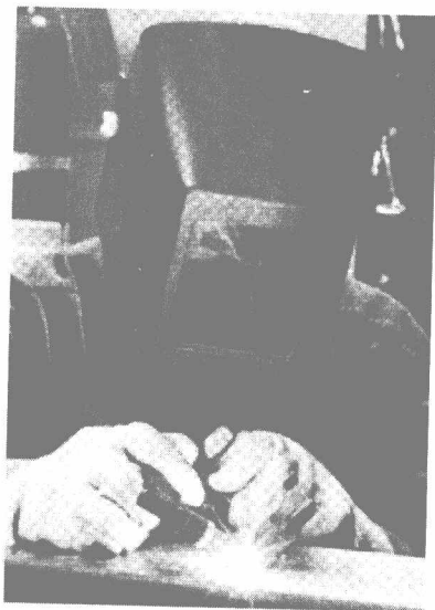
图 1.14 钨极氩弧焊
