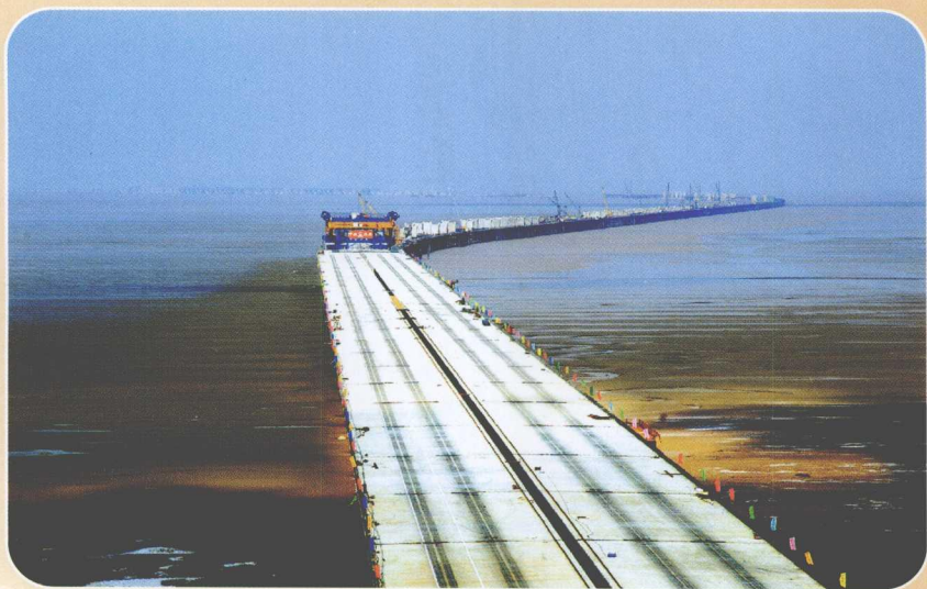
建设中的杭州湾跨海大桥
