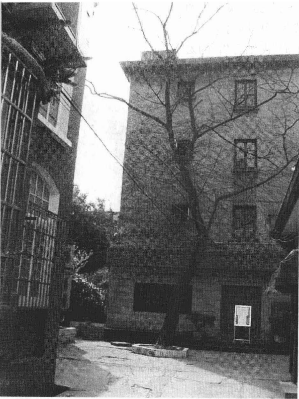
淮海中路1413号内,原上海美校的教学楼
