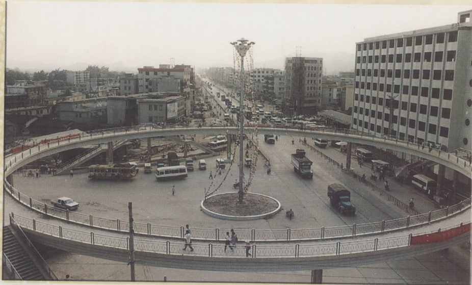
横跨广汕路的大型立交桥
