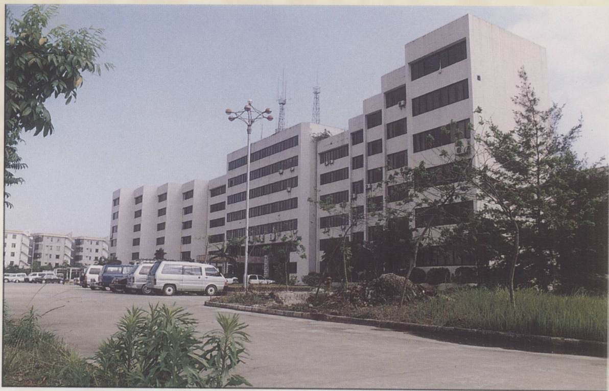
▲县委、县政府办公新址
