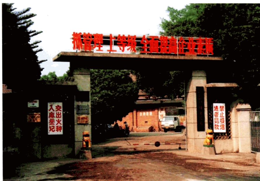
中国外运广西南宁 储运公司大门
