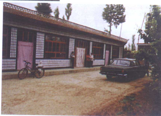
建设中的移民新居
