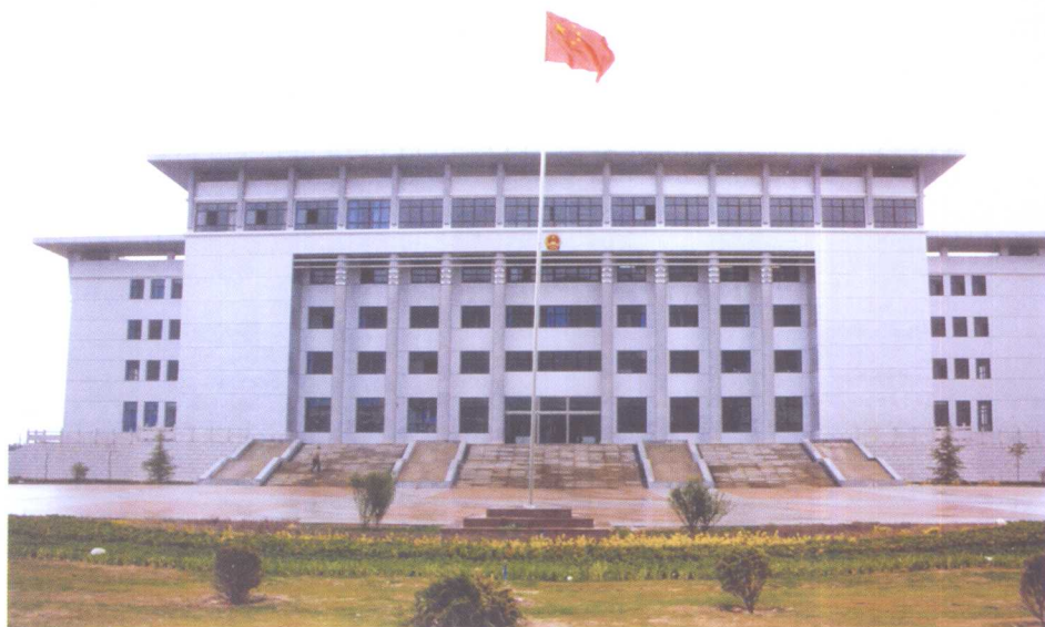
县党政综合办公楼
