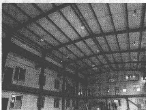
图 1.5 轻钢结构厂房门式刚架
