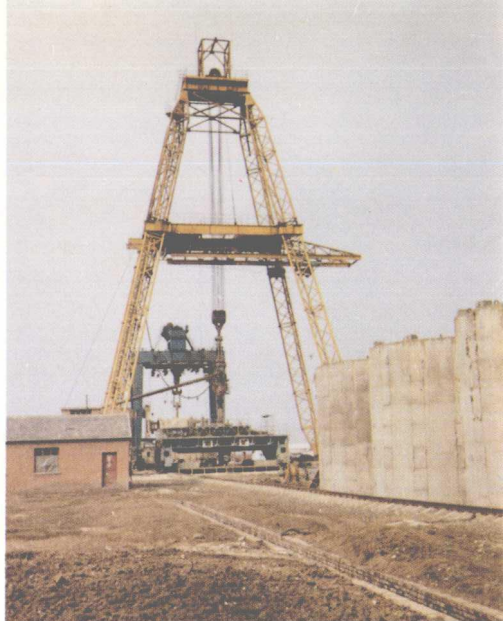
图十七 508米深井钻井法凿井
