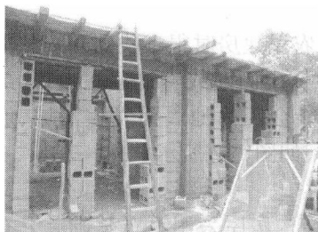
(e) 混凝土框架结构
