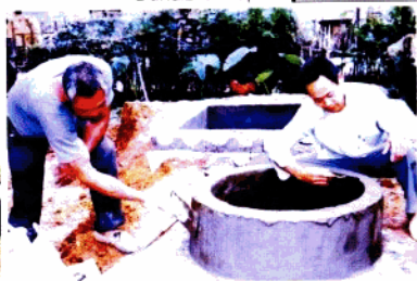
凤山县袍里乡月里村袍屯村民在建沼气池
