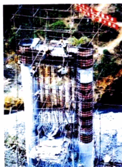
九圩至东兰二级公路施工情景
