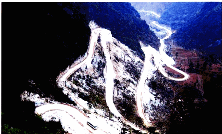
蜿蜒曲折的东兰县武篆镇弄竹通村四级砂石路
