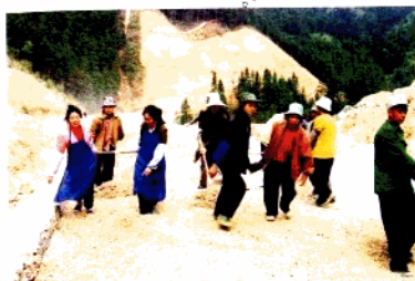
东兰至巴马二级公路施工场面
