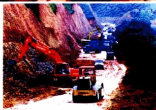
▲ 巴凤二级公路施工现场
