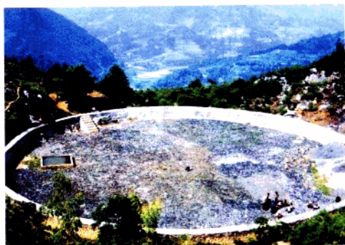
东兰县巴畴乡板加村大型水柜施工场面
