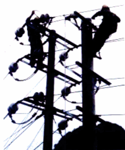
大会战电力工程项目施工场面
