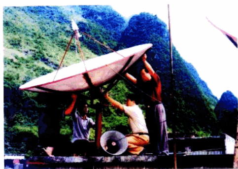
大会战村村通广播电视工程地面卫星接收器安装情景
