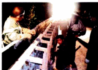
▲ 施工队在九圩至东兰二级公路东兰路段夜筑防护栏
