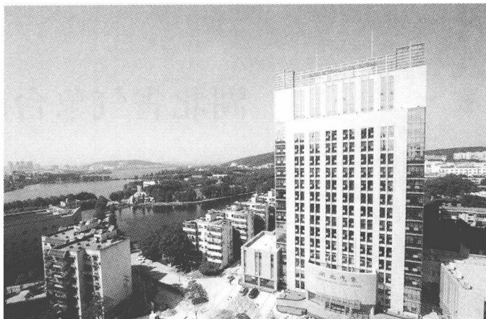
湖北省气象灾害预警中心大楼
