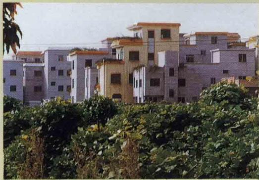
郊区澜石石梁村民居一角
