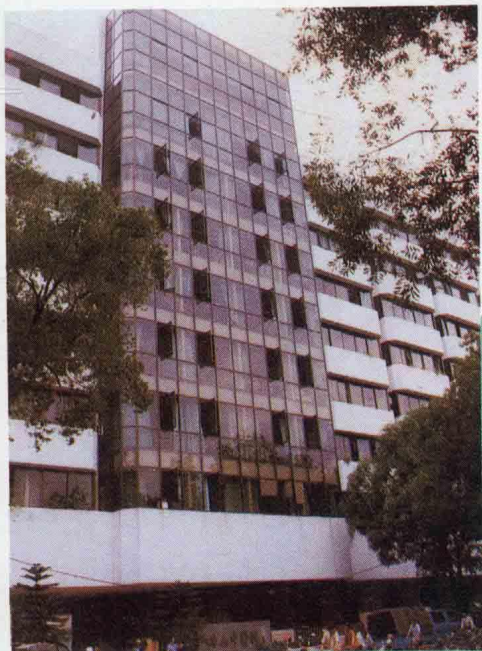
佛山中医院大楼
