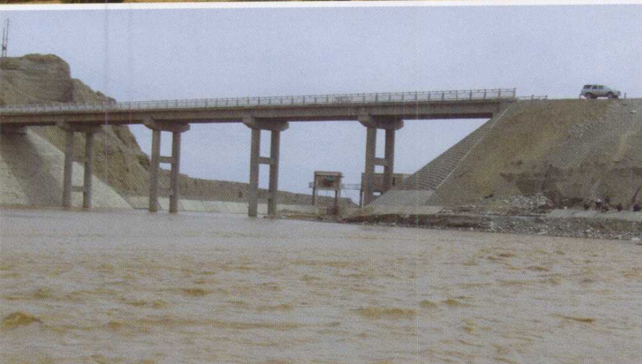
国家“兴边富民行动” 项目芦苇湾党河大桥
