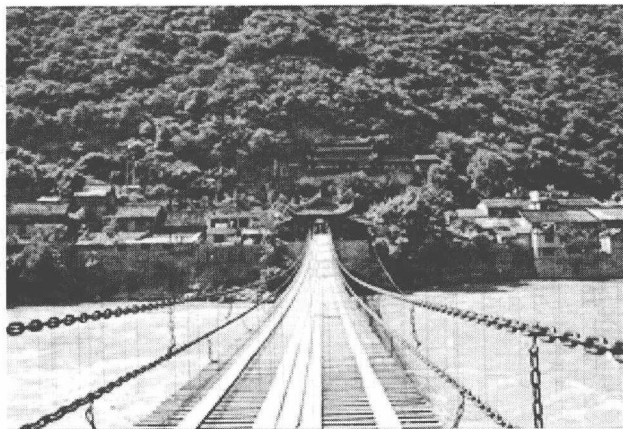
图 1.8 大渡河铁索桥——泸定桥
