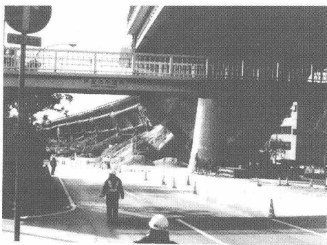
图 1.1.3 日本阪神地震中高架桥的破坏
