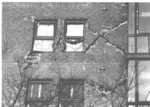
图 1.1.4 日本阪神地震中建筑物的破坏
