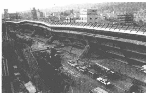
图 1.1.3 日本阪神地震中高架桥的破坏
