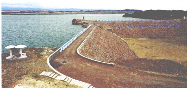
加音塔拉水库
