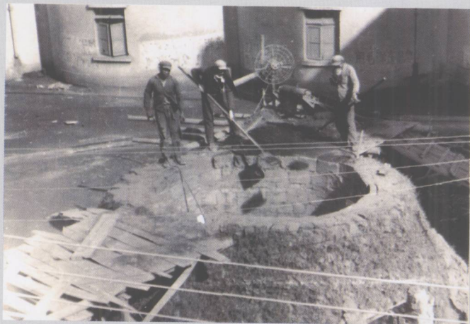
20世纪60年代南海水泥厂生料车间人工推斗倒石灰石进入一级破碎。
