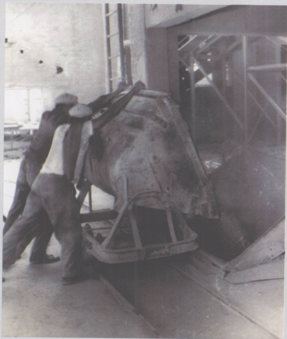
20世纪60年代南海水泥厂生料车间人工推斗倒石灰石进入一级破碎。
